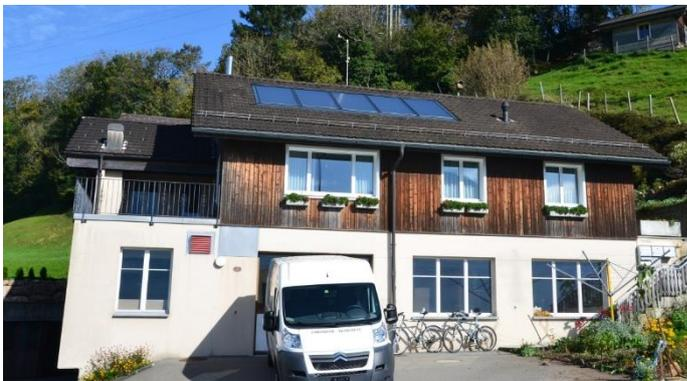
Der Elektroboiler für Warmwasser wurde mit Sonnenkollektoren auf dem Dach ausgetauscht, um erneuerbare Energie zu gewinnen.
