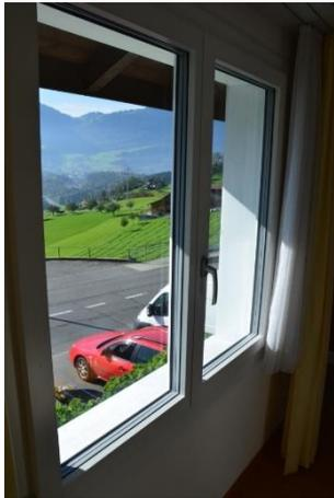
Alle Fenster wurden mit 3-fach Wärmeschutzglas UG-Wert=06.W/m<sup>2</sup> K und Holzmetallrahmen ausgetauscht und neu isoliert mit Innendämmung BPS 180 mm, Isofer Isoconfort 032 W/mK 0,032, 29 kg/m<sup>3</sup>, Dicke 160 mm.
