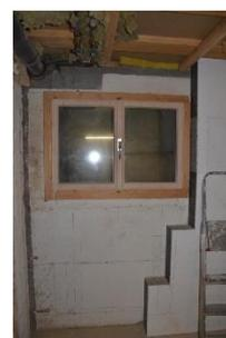
Innenisolation Isofer Isoconfort 032 W/mK Dicke 160mm
